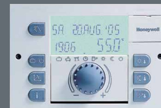
Instalación en panel
